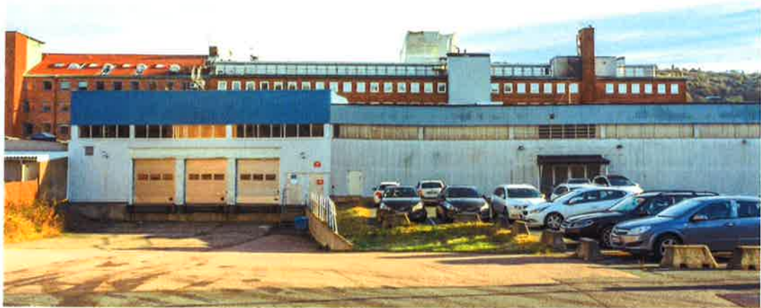
Befintlig lagerbyggnad som föreslås rivas. Foto av David Hansson.
