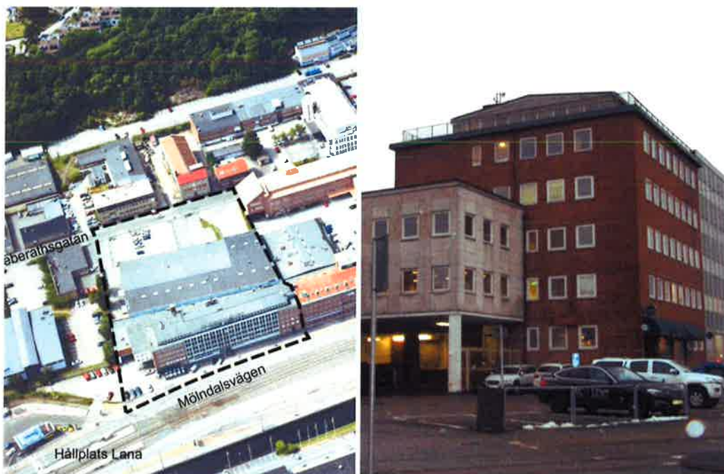
Tv. Snedbild från öster med planområdet markerat. Th. Befintligt kontorshus mot Mölndalsvägen.
