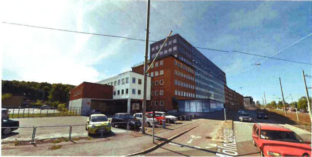
Fasad över föreslagen bebyggelse mot Mölndalsvägen, version påbyggnad med kontorsbyggnad i tre plan. Sett från söder. Mölndalsvägen till höger i bild. Illustration av Krok & Tjäder.
